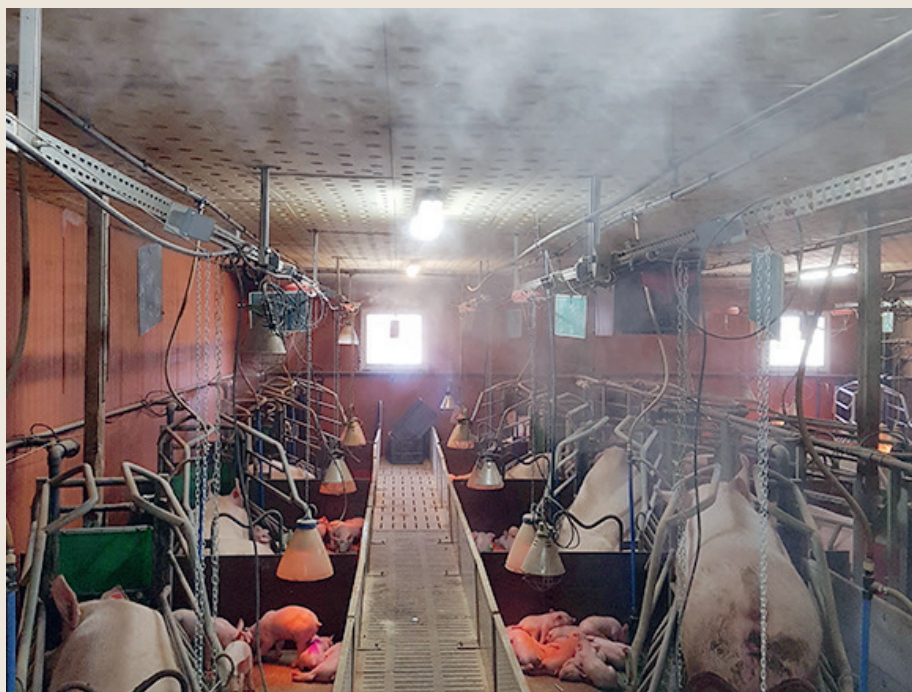
Система туманообразования высокого давления в маточнике
