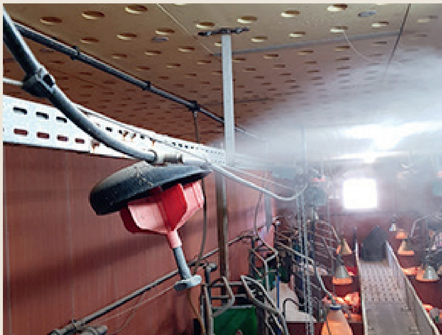
Ориентация сопел в горизонтальной плоскости, способствующая быстрому испарению капель.
